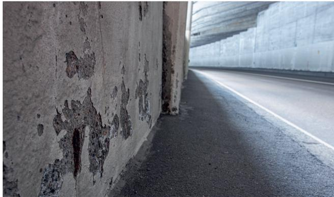
**Oben:** Das Alter und der Salzeinsatz haben für Schäden an den Bauwerken gesorgt **Unten:** das Nordportal des Casermettatunnels
